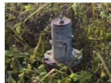
Caractéristiques : Le point d'eau incendie doit être muni d'un demi-raccord symétrique de sortie de 65 ou 100 mm avec raccord de réduction 100/65 mm amovible.
